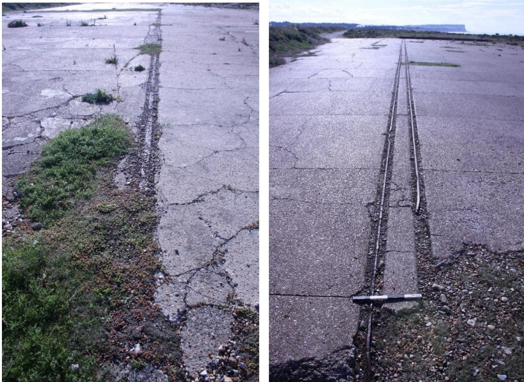
*FIGURE 71: IRON RUNNERS FOR THE SLIDING DOORS OF THE HANGARS*
