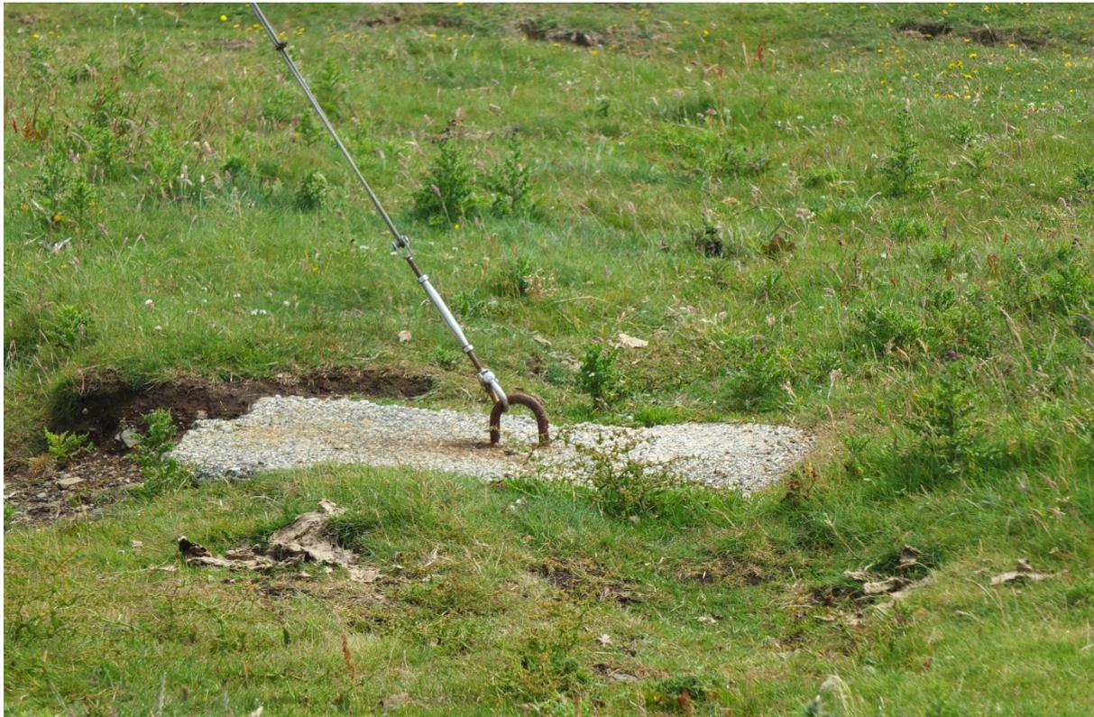
FIGURE 4.22: CONCRETE BLOCK USED TO TETHER THE STAYS OF THE MAST.
